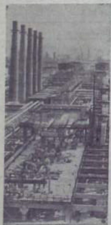
АЗЕРБАЙДЖАНСКАЯ ССР. 26 объектов комплекса этилена, первая очередь Сумгаитского химического комбината — Всесоюзной ударной комсомольско-молодежной стройки — накануне сдачи в эксплуатацию. В разгаре пуско-наладочные работы.
