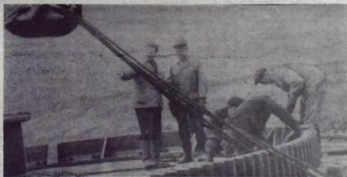
На снимке: монтаж опорной плиты мощного экскаватора ЗИШ-10-60, который ведет бригада Габдрауфа Батырева. Фото Ю. ЛАРИНА.
