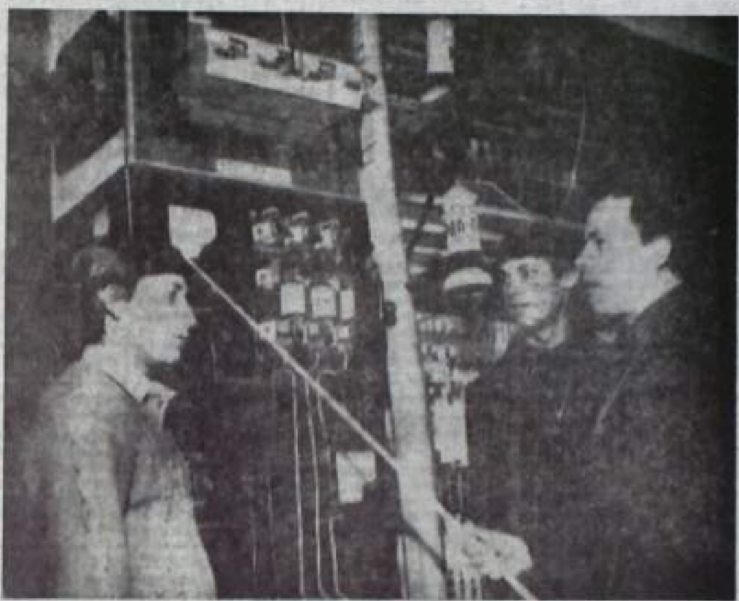
На снимке: в кабинете электрооборудования и электроснабжения горного предприятия. Ведет занятия А. П. Сулянов. Фото Н. МАГОРОВОЙ.
