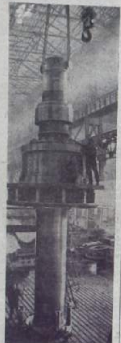
СВЕРДЛОВСК. На многих электростанциях нашей Родины и за ее пределами работают гидрогенераторы завода Уралэлектротяжмаш имени В. И. Ленина. Миллиарды киловатт электроэнергии выработано ими для народного хозяйства. Сейчас на заводе закончена сборка трех крупных машин для Саратовской ГЭС.
