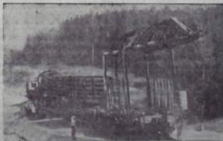
Татарская АССР. 125-километровая железнодорожная ветка прокладывается в южном направлении от узловой станции Агрыз до Набережных Челнов. Ее успех позволит лучше регулировать грузопотоки на железнодорожных направлениях: Москва—Казань—Свердловск и Москва—Уфа—Челябинск. Дорога пройдет по платине Нижнекамской ГЭС.
