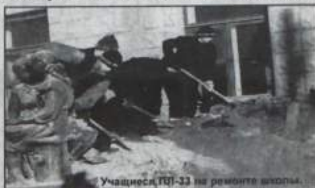
Учащиеся ЦОП-33 на ремонте школы.
