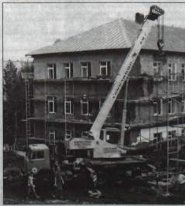
Работы ведутся на втором спальном корпусе БРГИ №3.
