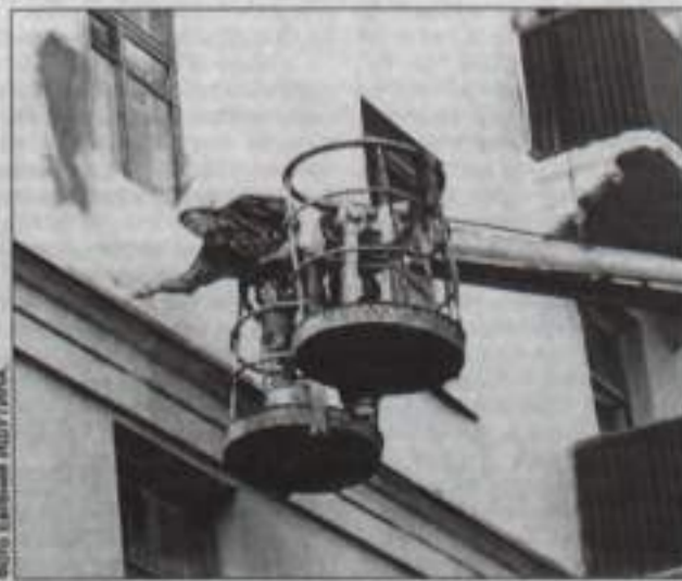
Ремонт фасада одного из домов по улице К. Маркса.
