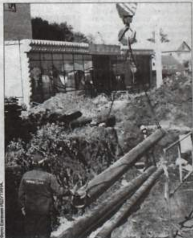
Работы по улице Комсомольской.
