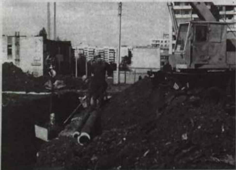
Замена тепловых сетей по улице Энергетиков.
