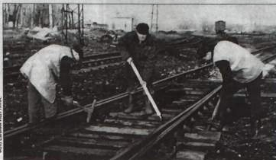
Демонтаж железнодорожных путей производят монтеры МУП «Локомотив».
