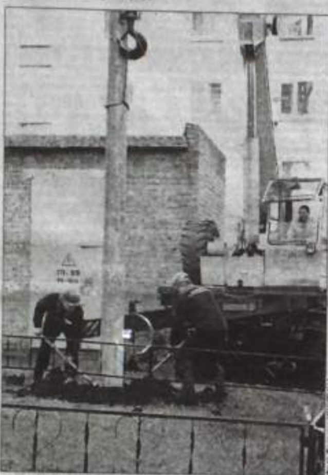
Замена поврежденной опоры.
