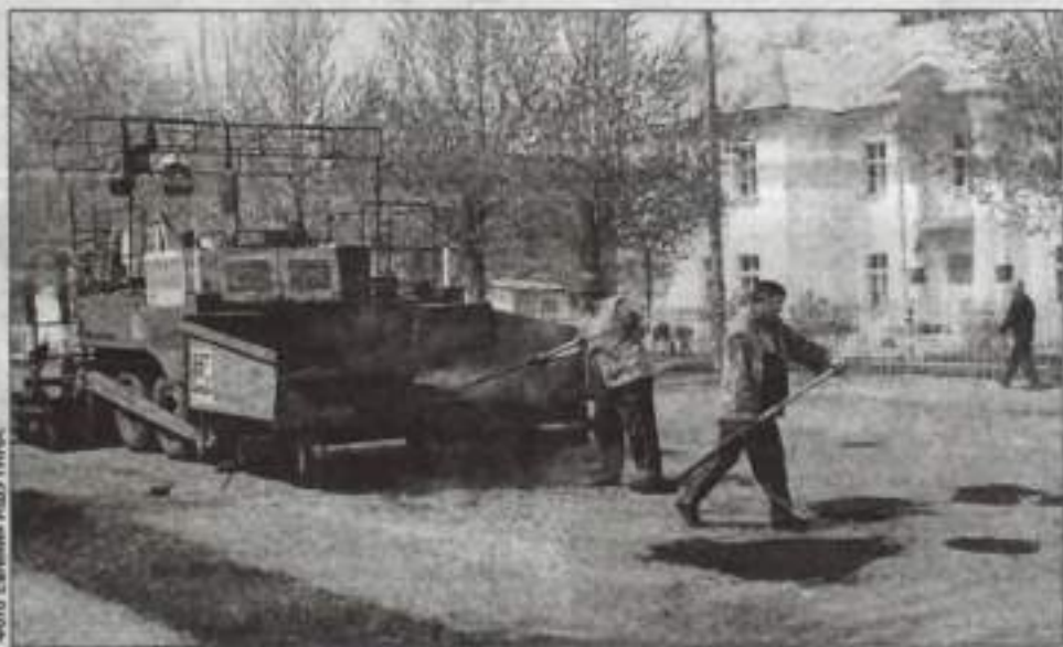
Асфальтировщики МАУ ДОР выполняют ямочный ремонт дорожного полотна на участке в районе РКМЦ «Дуслык».
