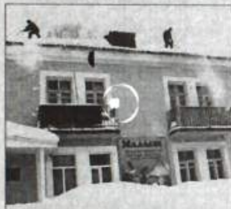
На крышах домов работают кровельщики РЭУ №1.
