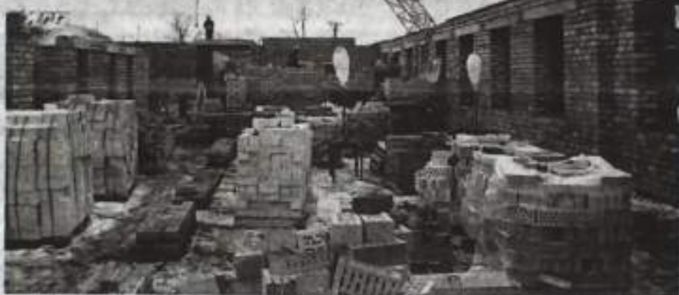
Строительство лечебного корпуса в Киргиз-Мияхи.
