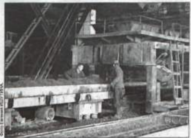
В формовочном отделении МП «Стройиндустрия» идет изготовление бетонных плит перекрытия для строительства жилья и других объектов.
