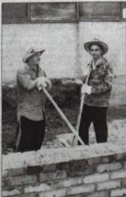
Каменщики С. Кузьмин и В. Николаев на строительстве котельной.
