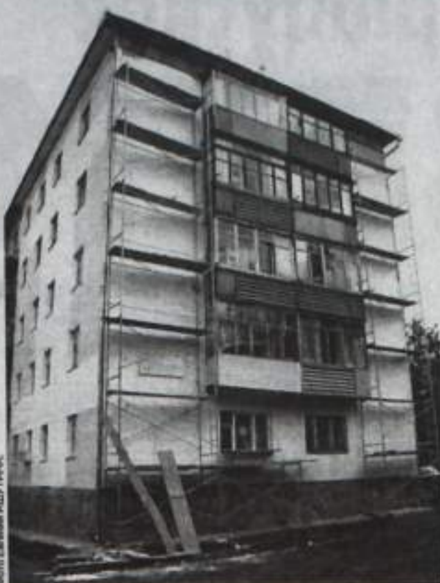
Дом №3 по ул. Дзержинского. Здесь идет ремонт.
