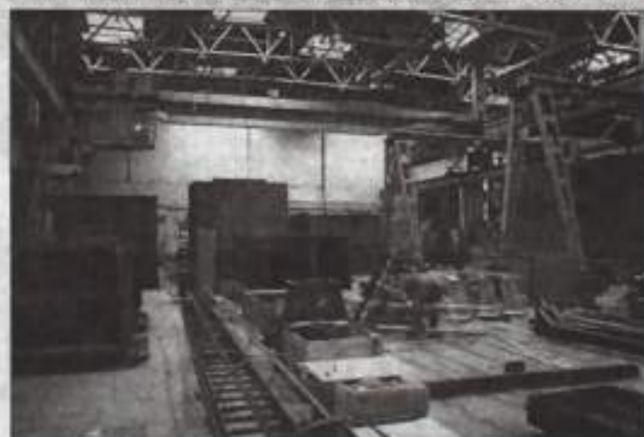
В работе – оборудование для цементных заводов.
