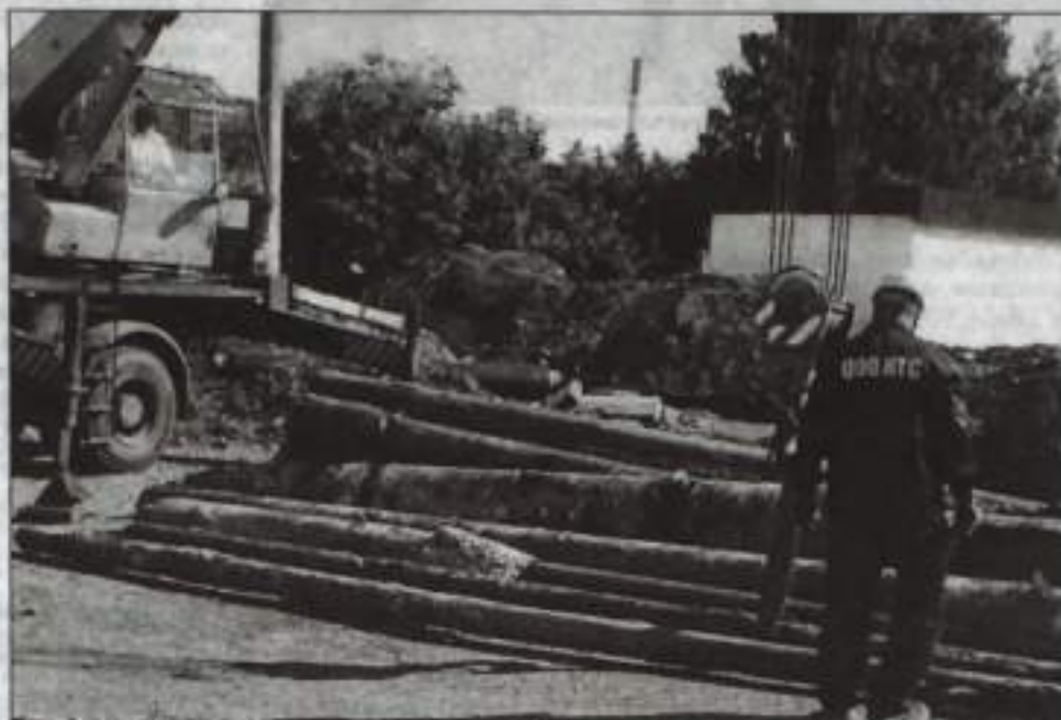
Капитальный ремонт квартальных теплосетей.
