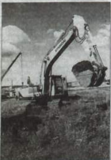
Строительная техника приступила к работе.
