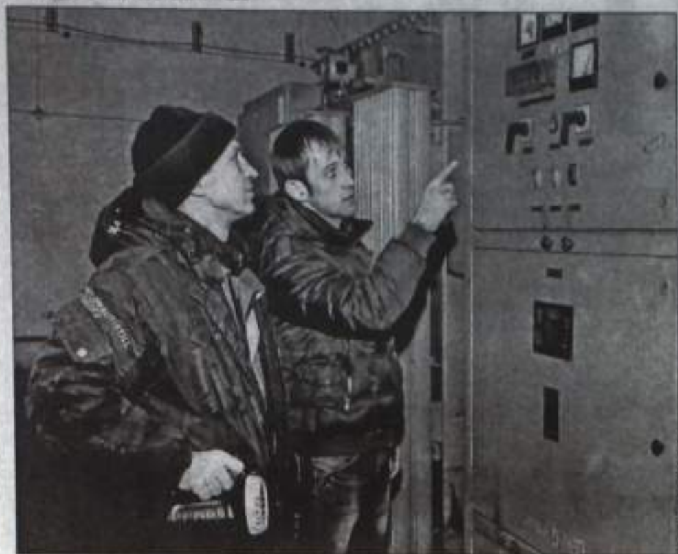
Идёт контрольный осмотр ТП-6.
