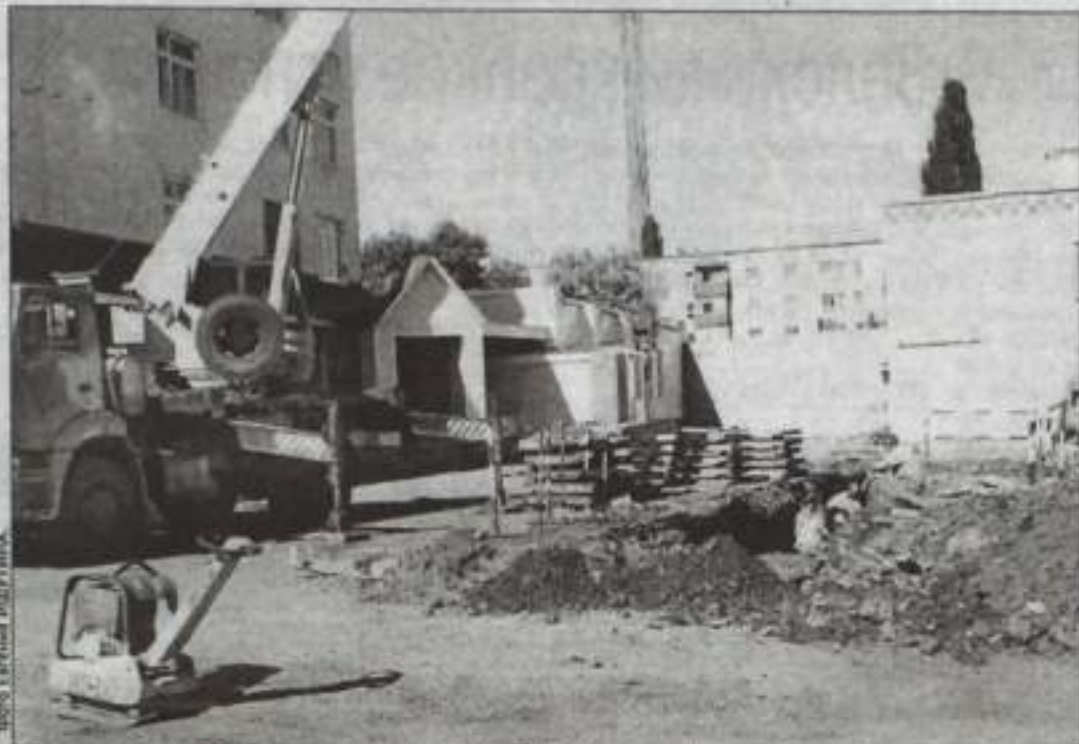
Строительство непроходного канала на территории поликлиники.
