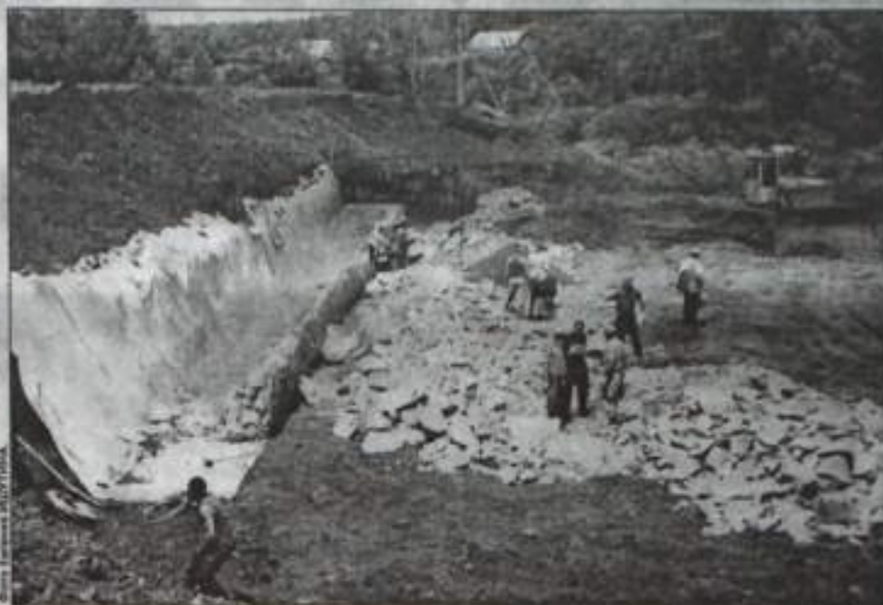
Строительство перепропускной траншеи.
