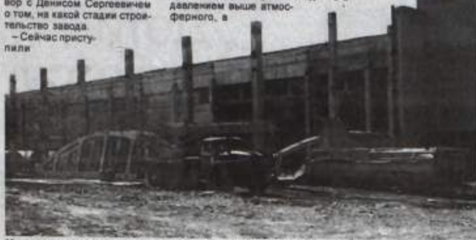
Медленно, но верно продвигаются работы по строительству завода.
