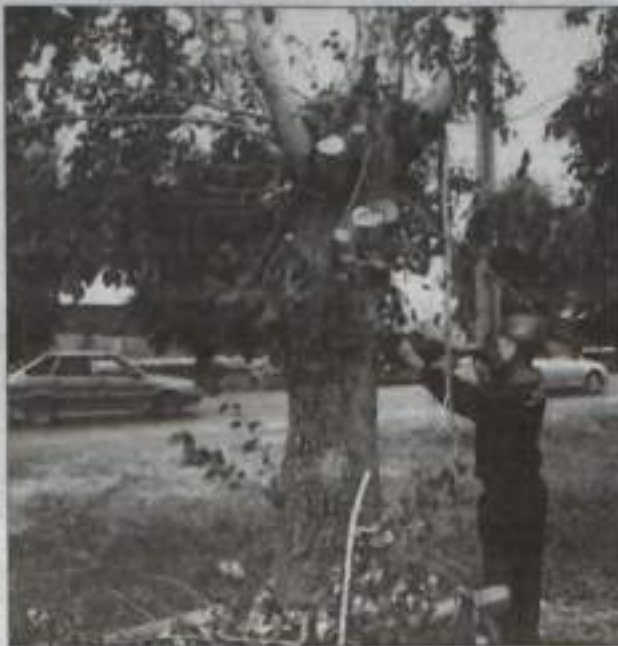
Проведена опилка древесно-кустарниковой растительности в охранной зоне воздушной линии электропередачи.
