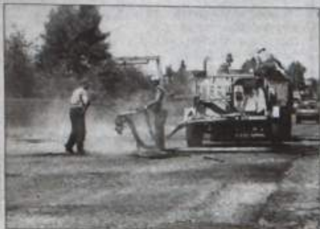
Ремонт дороги идет полным ходом.
