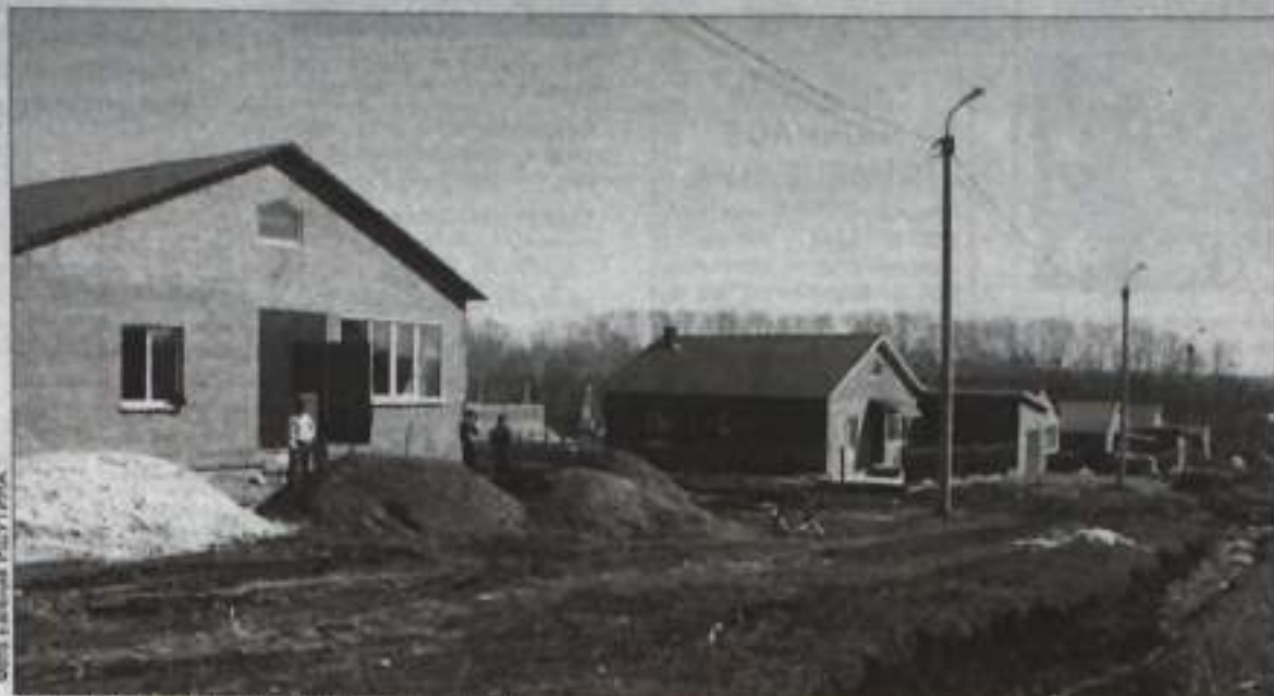
Новая улица в микрорайоне Шахтерский-3.
