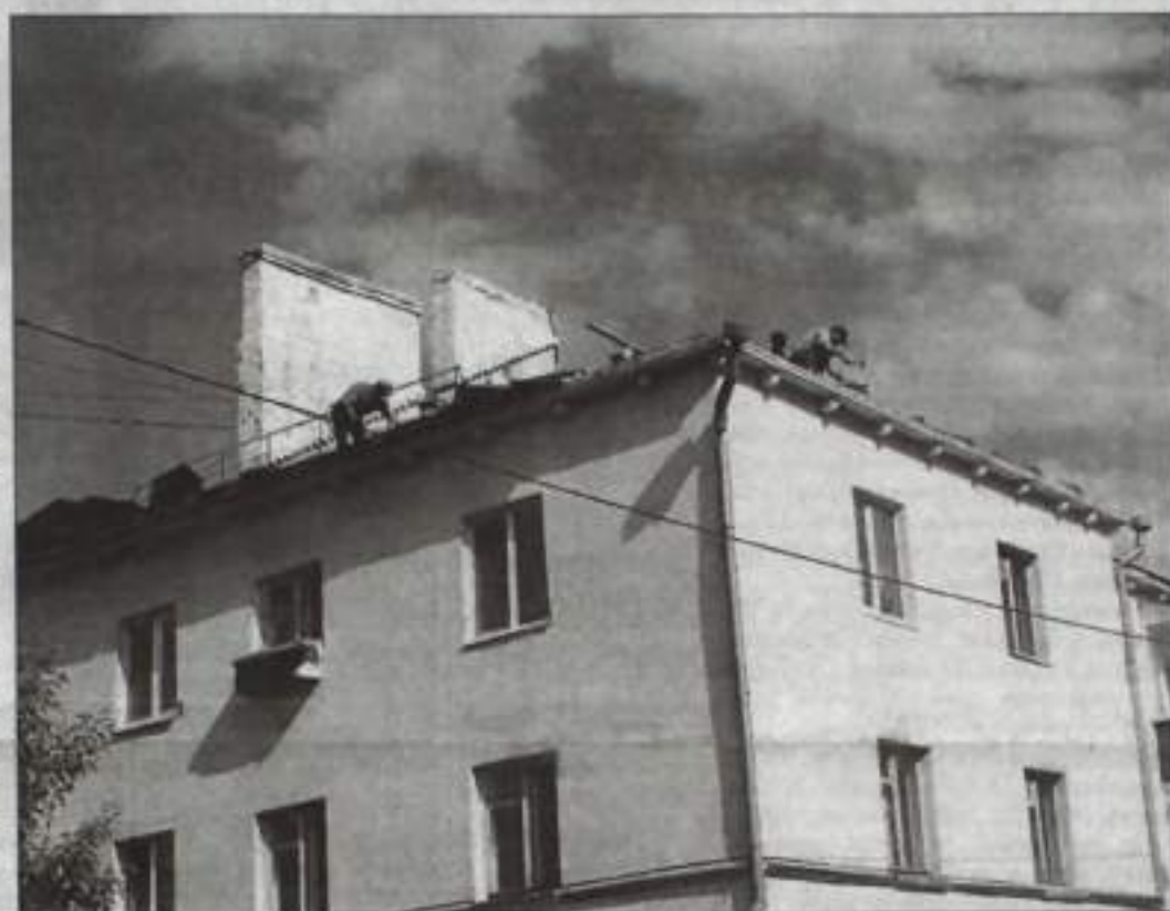
Ремонт кровли дома №21 по улице Ленина ведёт ООО «Драйф» (Уфа).
