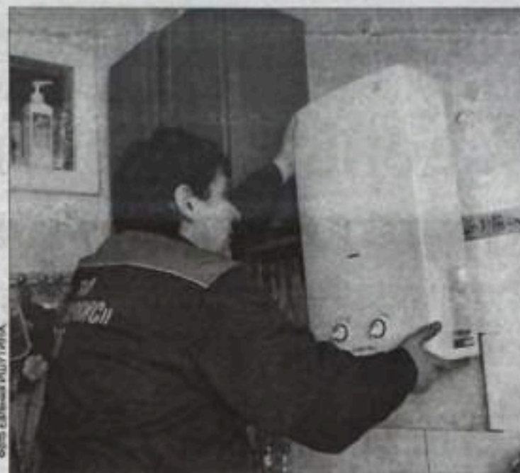
Слесарь устанавливает новую газовую колонку.
