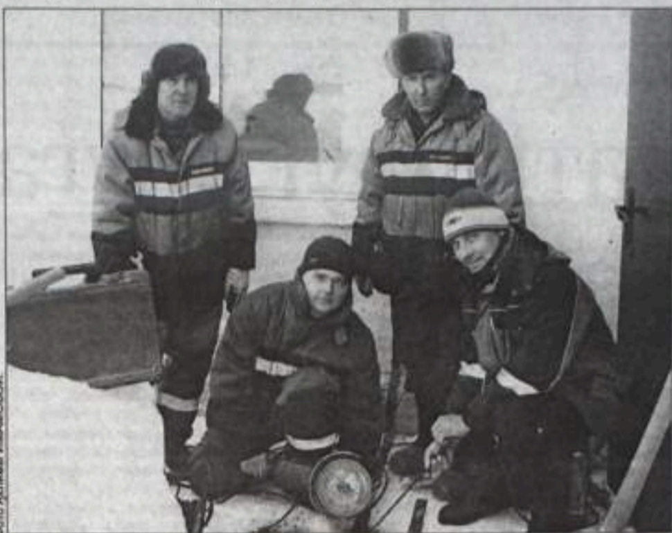
Бригада устанавливает заземляющее устройство в здании ОГУ: слева направо - Булат Бурангулов, Евгений Никлов, Мухамет Шангареев, Алексей Куталь.
