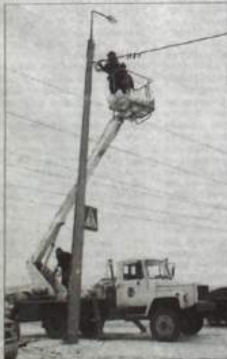
Идет замена старых проводов по ул. Шоссейной.
