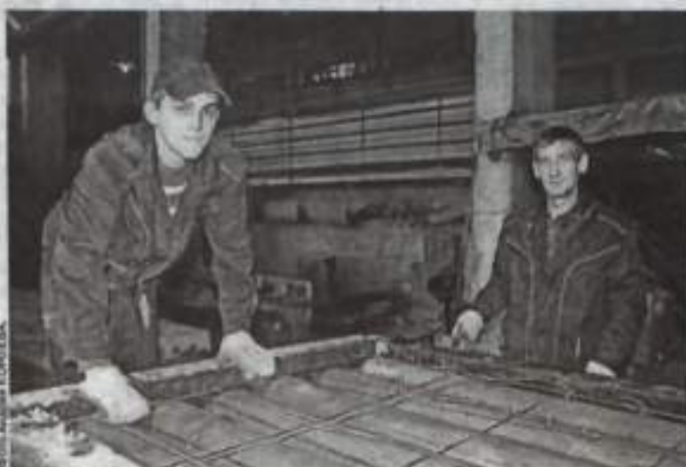
Так из арматуры и бетонной смеси формируют плиты.
