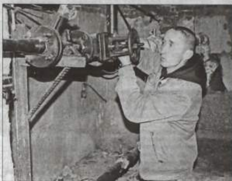
Слесарь РЭУ №6 Тимур Мухаметов занят регулировкой элеваторного узла.
