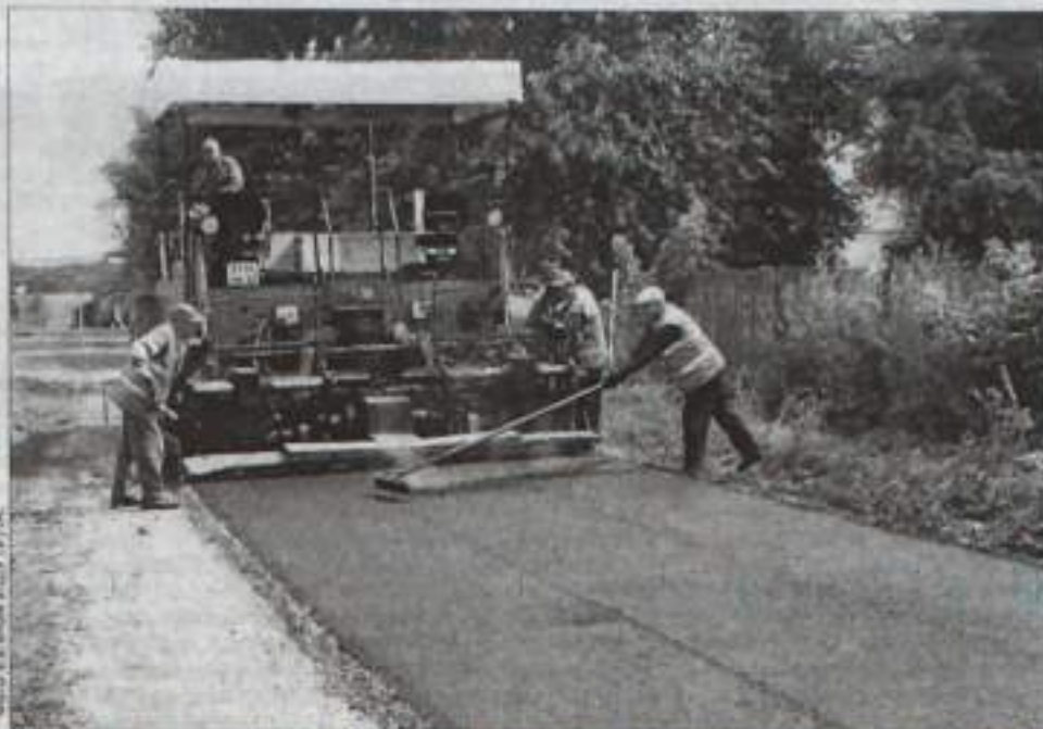
Ремонт дороги в селе Майчом.
