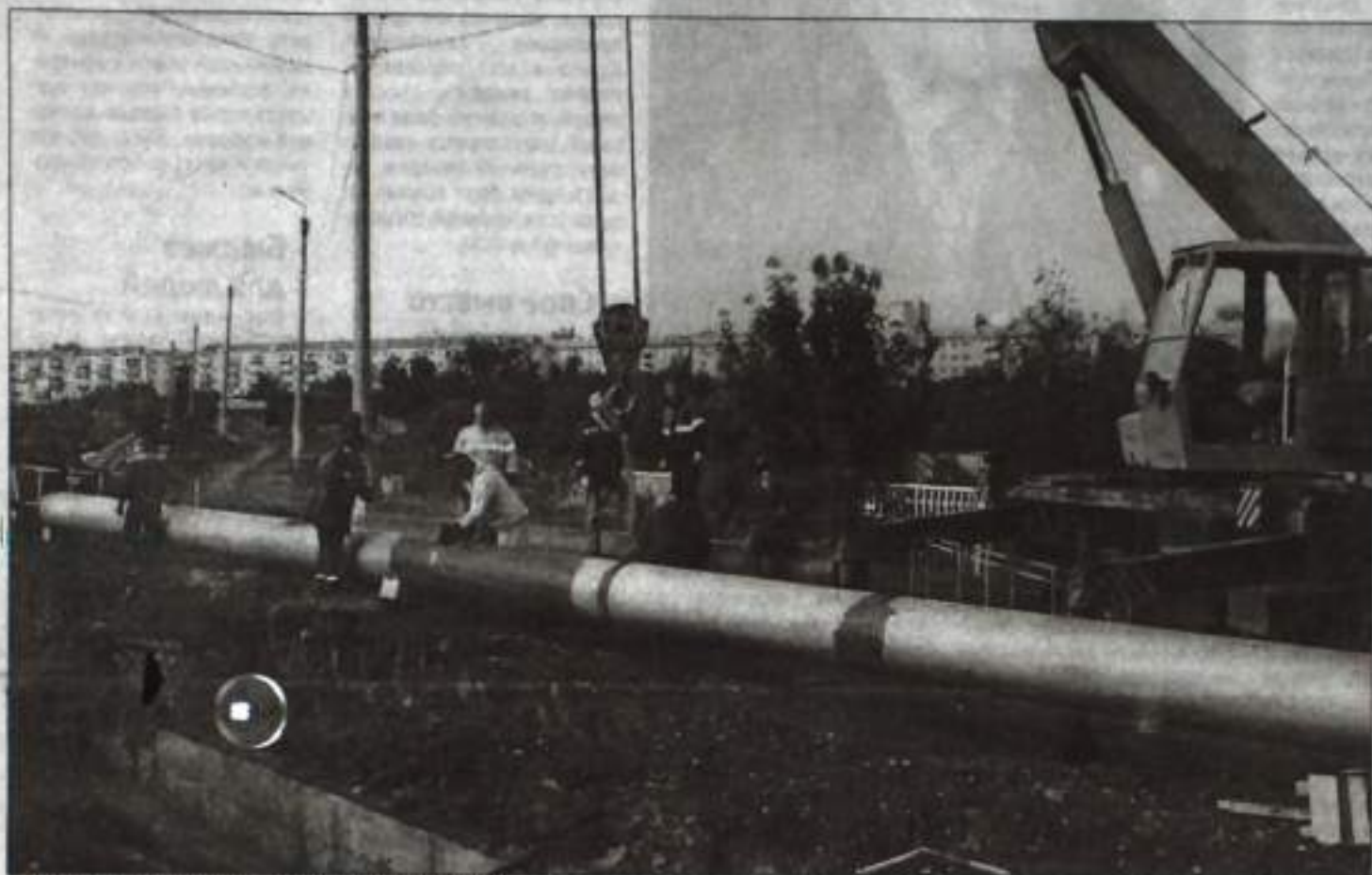
Ремонт магистральных сетей по улице Бабаевской.
