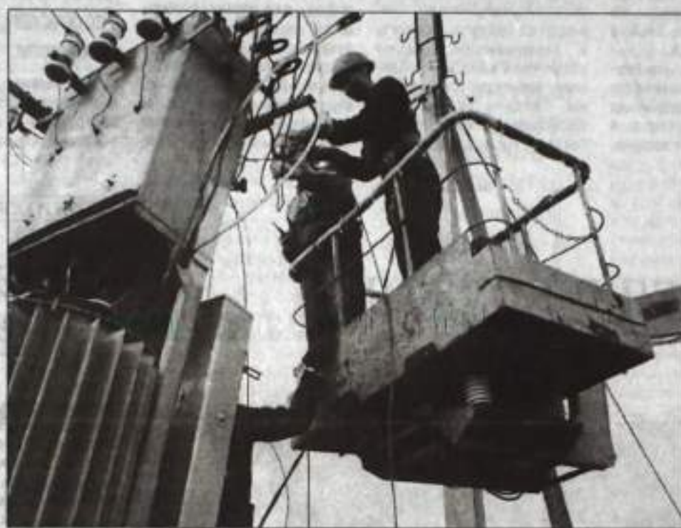
Ремонт воздушных линий.
