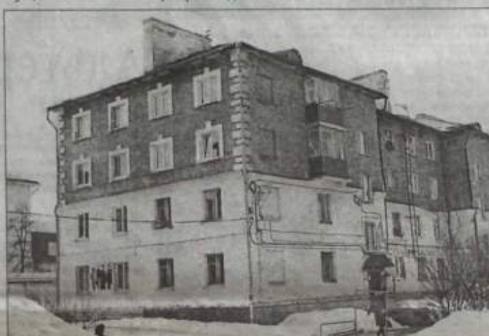
В текущем году Региональный оператор гарантирует проведение капремонта общедомового имущества 27 домов города, в том числе будет отремонтирован и дом №20 по улице К.Маркса.
