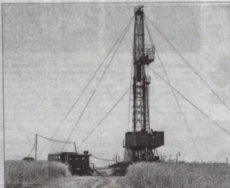
Проведение капитального ремонта скважин работниками филиала ООО «Газпром ПХГ» «Башкирское УАВР и КРС».
